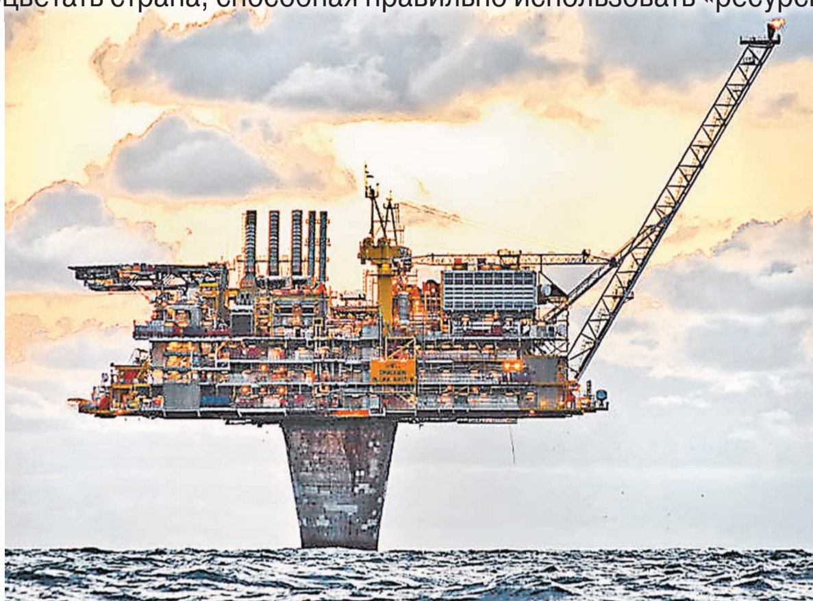
Норвежская нефть в отличие от российской залегают только на шельфе Северного и Баренцева морей, поэтому для её добычи строят уникальные морские платформы. На фото: морская платформа Draugen - чудо инженерной мысли. Стоит на одной 280-метровой бетонной ноге, причём 250 метров находятся под водой.
