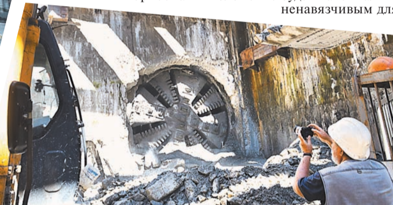
Ещё один тоннель на участке «Лефортово» - «Авиамоторная» Большой кольцевой линии готов.
