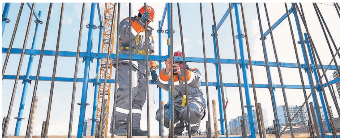
Согласования уходят в Интернет, чтобы строители могли сосредоточиться на своей главной задаче - возводить удобные и безопасные дома. Фото Эдуарда КУДРЯВИЦКОГО
