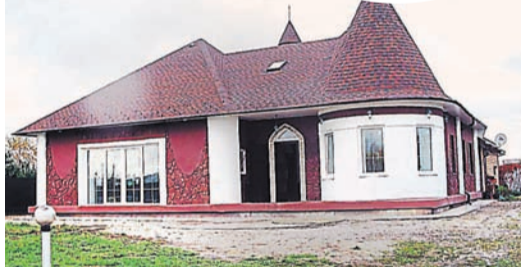
Срок эксплуатации дома - 150 лет (на фото в кружке - строительный принтер).
