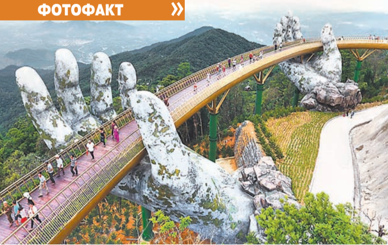
ФОТОФАКТ Во Вьетнаме открыли необычный мост - кажется, что его держат две гигантские руки. На самом деле руки декоративные, а опоры служат стальные столбы, забетонированные в горную породу. Строительство моста заняло около года. Он расположен на высоте 1414 метров над уровнем моря, длина 150 метров. Фото trinity.ru
