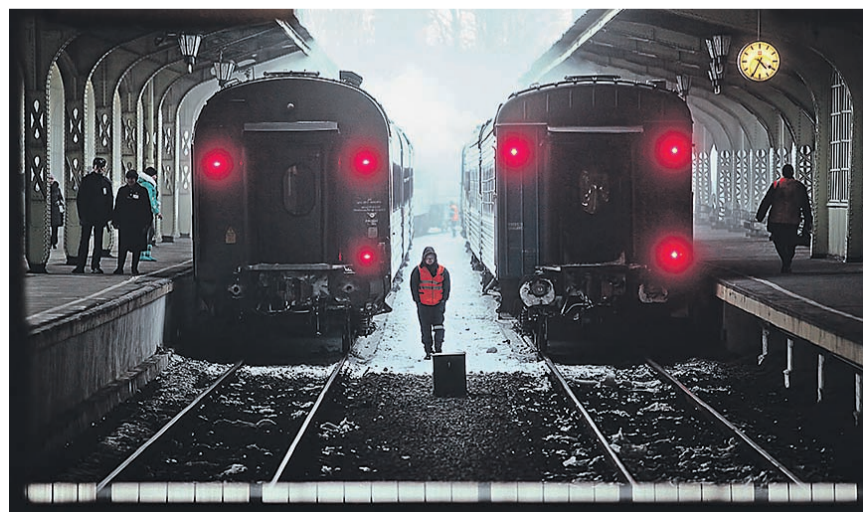
Цель строительства магистрали — сократить время в пути между Москвой и Казанью до 3,5 часа
