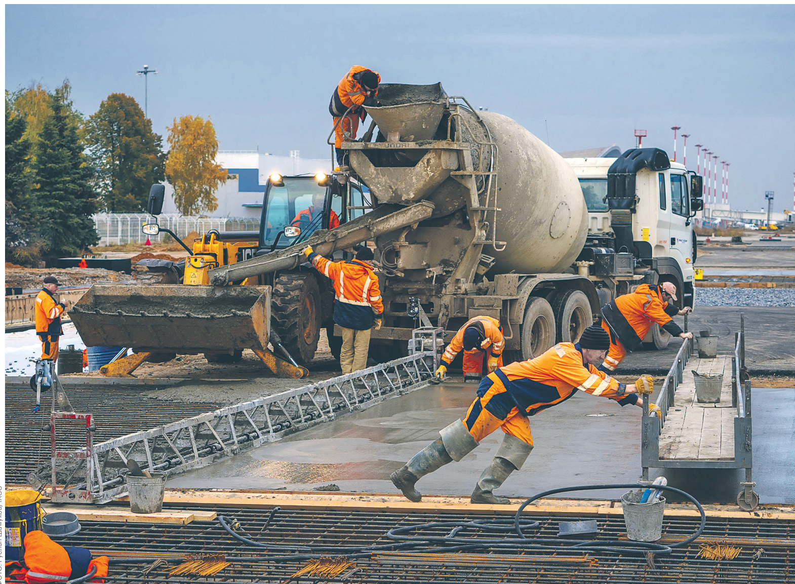
Из Фонда развития будут профинансированы реконструкция и строительство региональных аэропортов по всей стране. На фото: реконструкция на территории международного аэропорта Курумоч в Самаре
