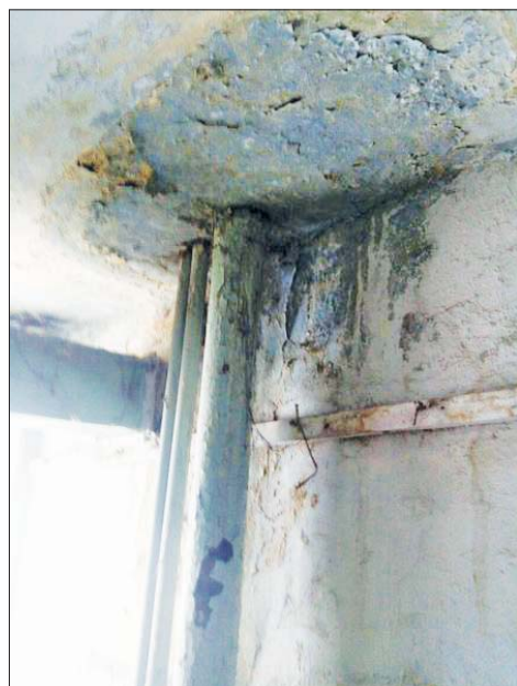
Старые трубы в доме по улице Булавина постоянно засоряются. Фото предоставлено Михаилом Гавриловым.
