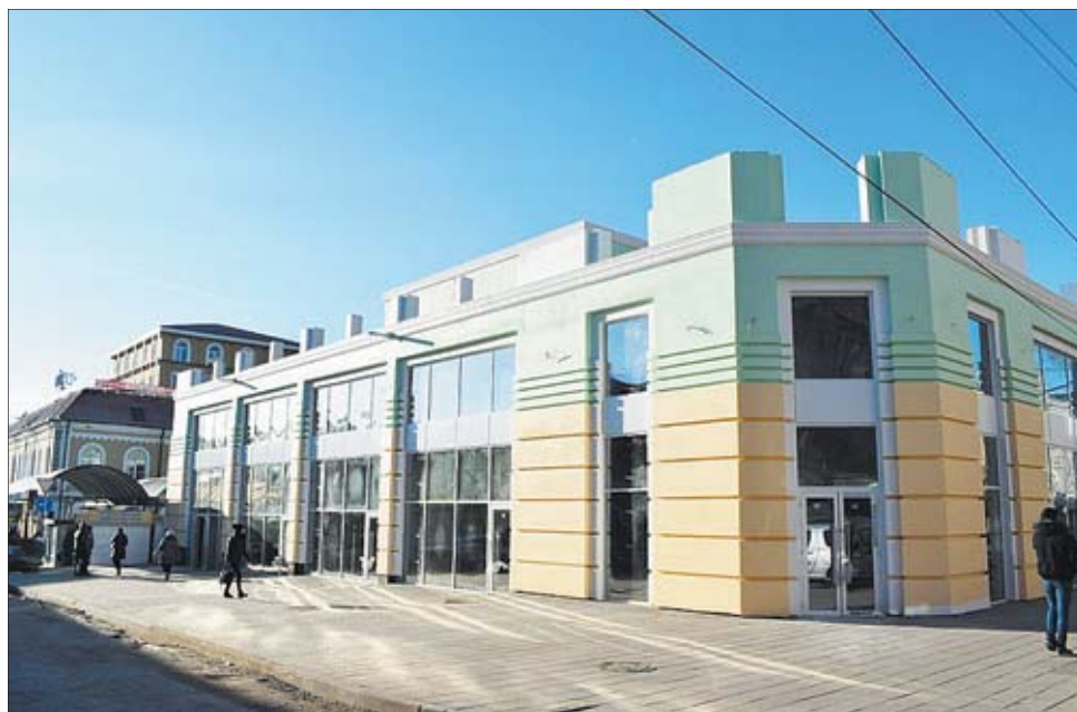
Весной 2017 года завершился снос старого здания. От прежнего «гиперларька» в новом объекте остался только фундамент.
