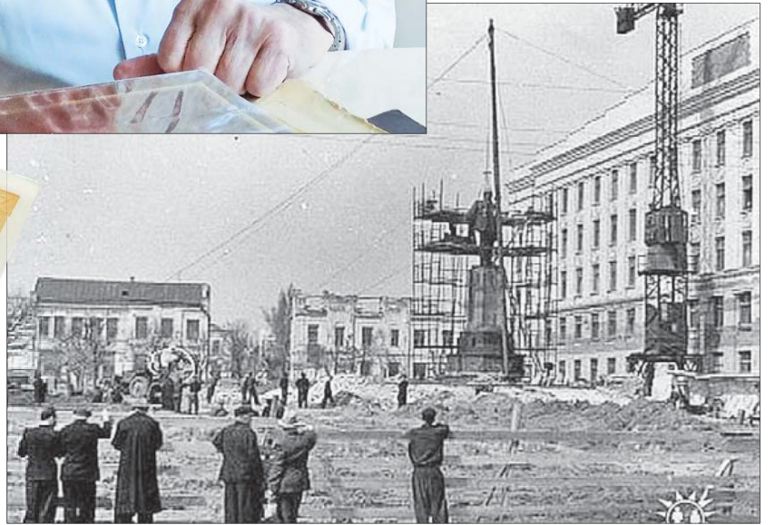
Строительство «Дома Советов».
