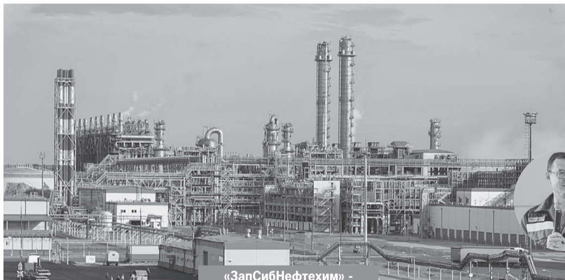
«ЗапСибНефтехим» - крупнейший нефтехимический комплекс России.
