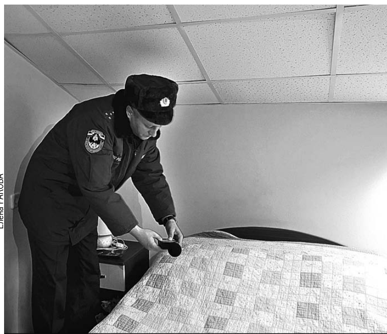
В гостинице торгового комплекса «Никита» спящий человек может попросту не услышать оповещение о пожаре.
