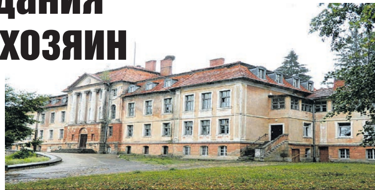
Здание районного управления в Железнодорожном давно требует внимания.
