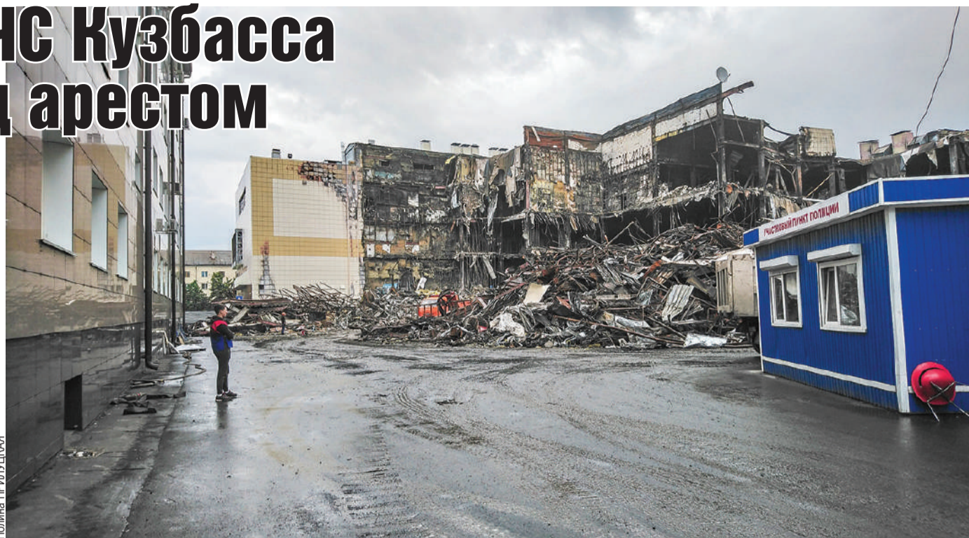
Продолжаются работы по сносу здания «Зимней вишни», в котором 25 марта произошла страшная трагедия.
