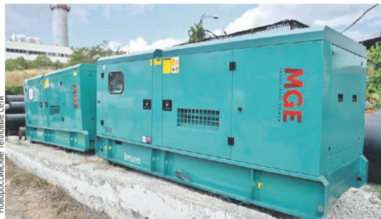
В случае непогоды поддерживать стабильное теплоснабжение в Новороссийске будут благодаря новым дизель-генераторам.
