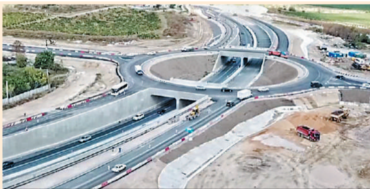
Реконструкция Ялтинского кольца - одна из самых крупных инфраструктурных работ города-героя.
