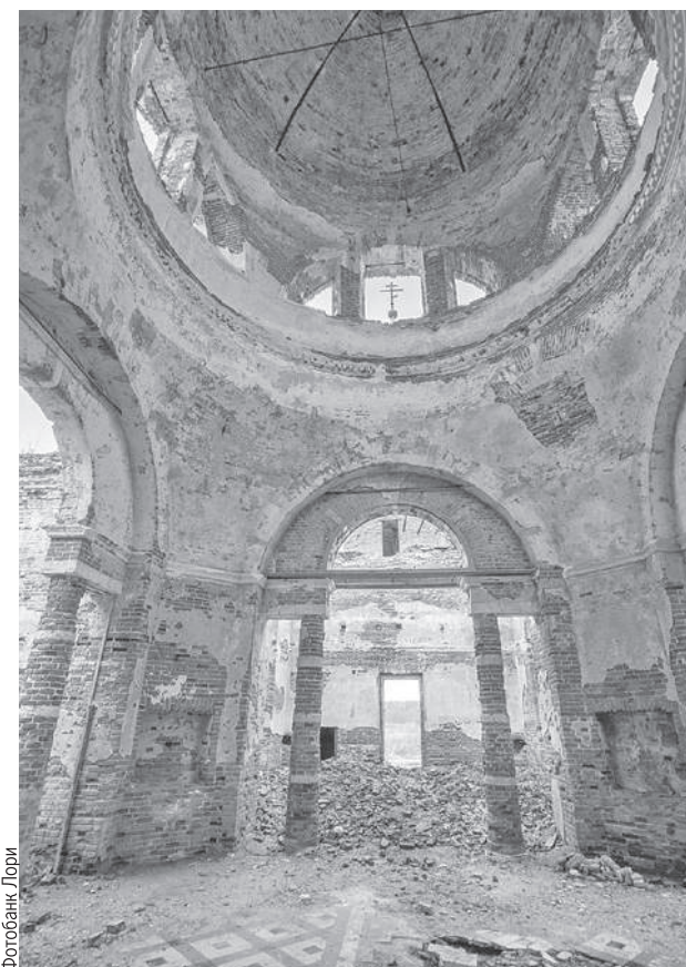
Знаменская церковь в урочище Теплое, Московская область.
