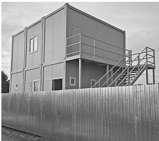
Незаконная постройка на дамбе.
