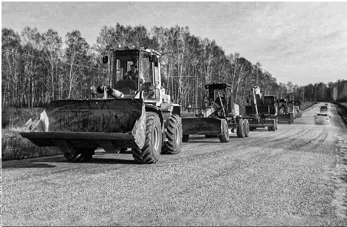
В Аромашевском районе открыт участок автодороги Балахлей - Новоберезовка.
