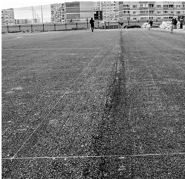
Подрядчик приступил к укладке резинового покрытия на спортивной площадке школы на улице Арктической.
