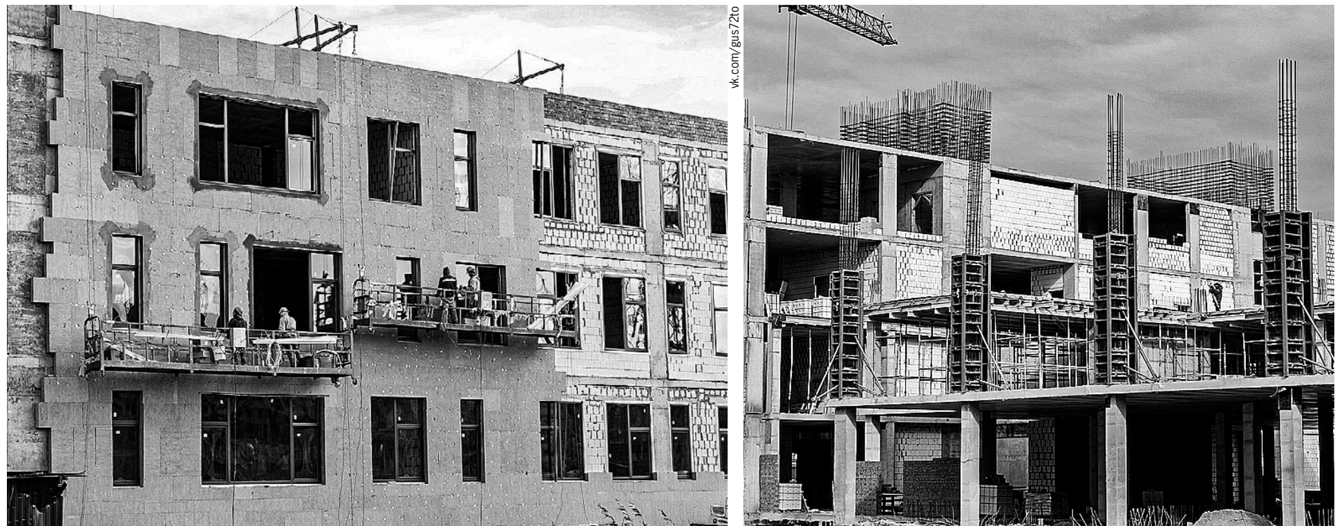
В микрорайоне Плеханово Тюмени ведется строительство школы на 1500 мест. Каркас здания одной из самых крупных школ в Тюмени готов на 85%.
