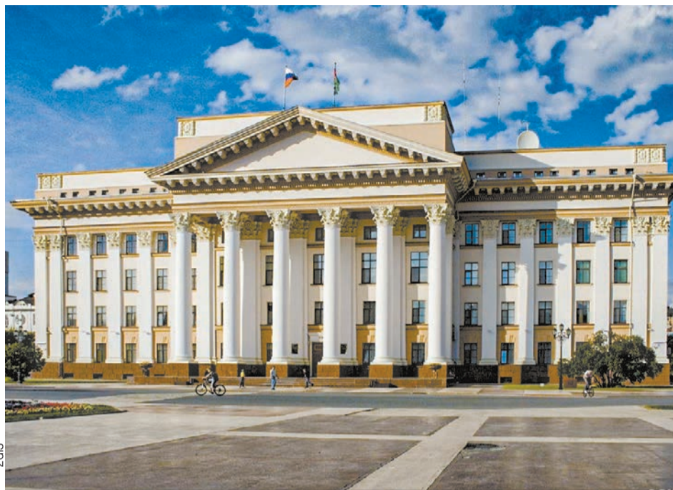
В здании демонтируют три лепных изделия и изготовят новые.
