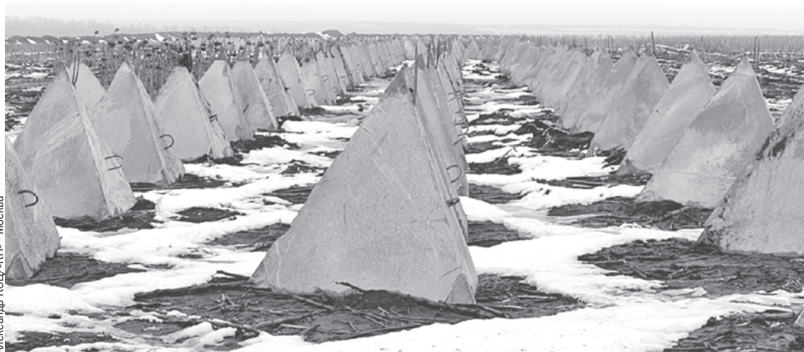
Рубежи ЛНР обкладывают вот такими бетонными пирамидами, которые никакая бронетехника с ходу не пройдет. Солдаты называют их «зубы дракона».
