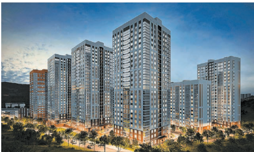
Сейчас ведется строительство третьей очереди ЖК «Меридианы Улисса».
