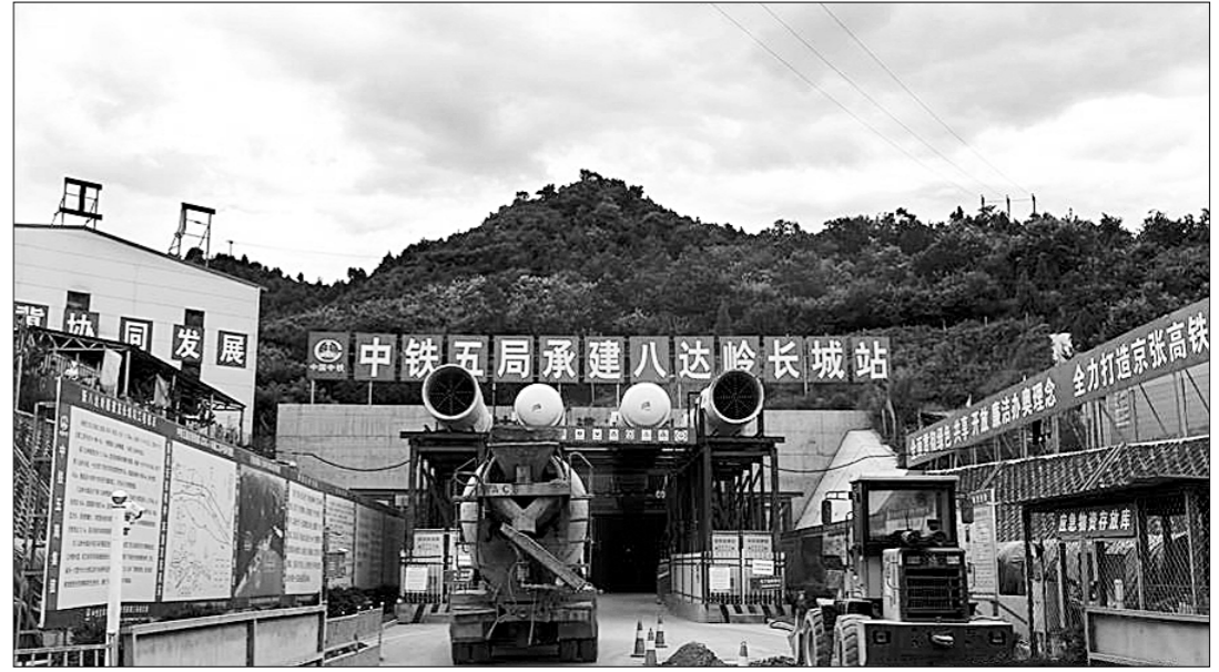
Под участком Бадалин Великой Китайской стены в окрестностях столицы КНР и под старой железной дорогой Пекин — Чжанцзякоу развёрнулось строительство подземной станции новой высокоскоростной железнодорожной магистрали Пекин — Чжанцзякоу.
