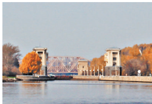
Шлюз № 4 на канале Москва — Волга построен по проекту Александра Пастернака.
