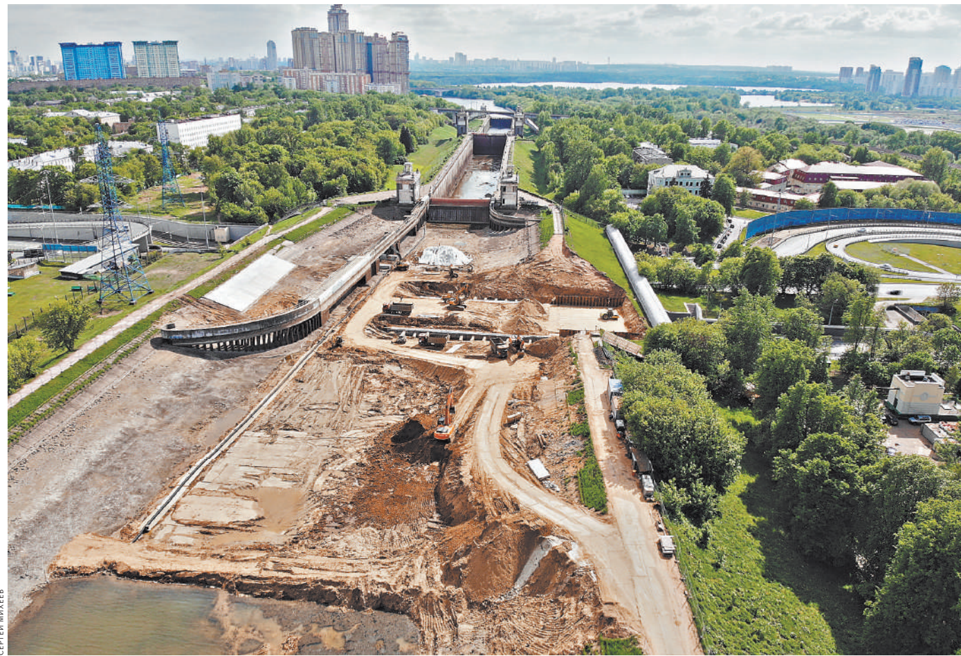
Пока еще можно наблюдать уникальную картину — осушенного канала, проходящего над автотоннелем, нет части стены — ее сейчас реконструируют.
