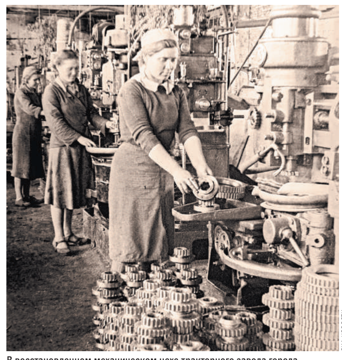
В восстановленном механическом цехе тракторного завода города Сталинграда. 1944 год.
