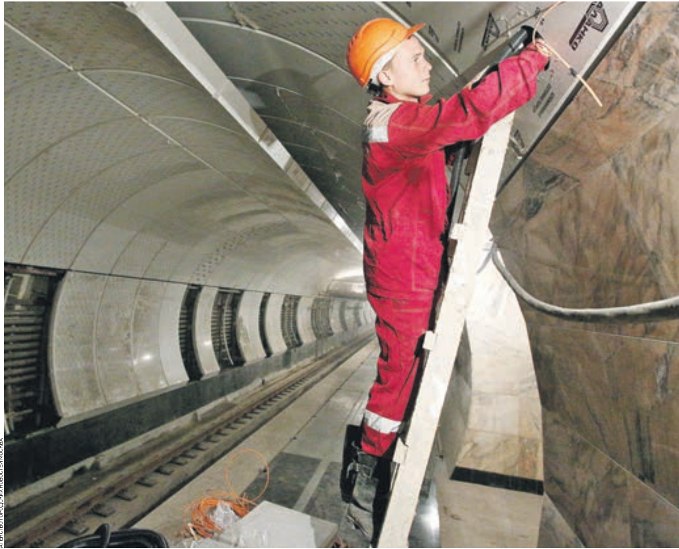
5 сентября 2016 года 17:59 Новая платформа на станции метро «Бутырская». Метростроители завершают работу: взобравшись на леса, они монтируют приборы освещения. На стенах закрепляют вывески с названием станции и устанавливают информационные панели
