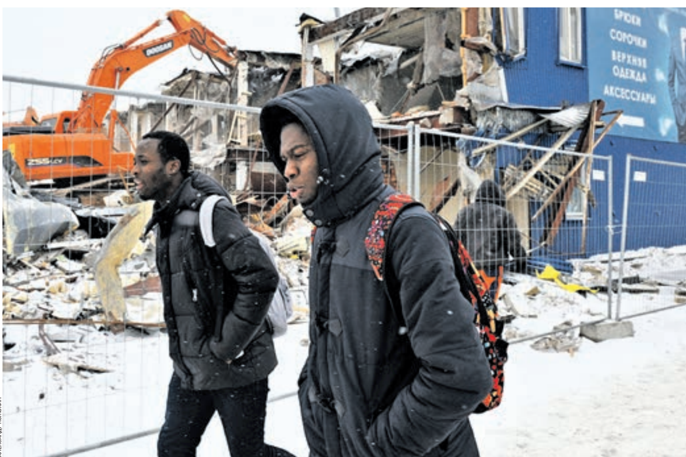
Вчера 12:35 «Петровско-Разумовская». Снос незаконно возведенного рынка почти завершен. Этот объект также вошел в список самостроя, подлежащего демонтажу. На его месте скоро появится современный транспортно-пересадочный узел
