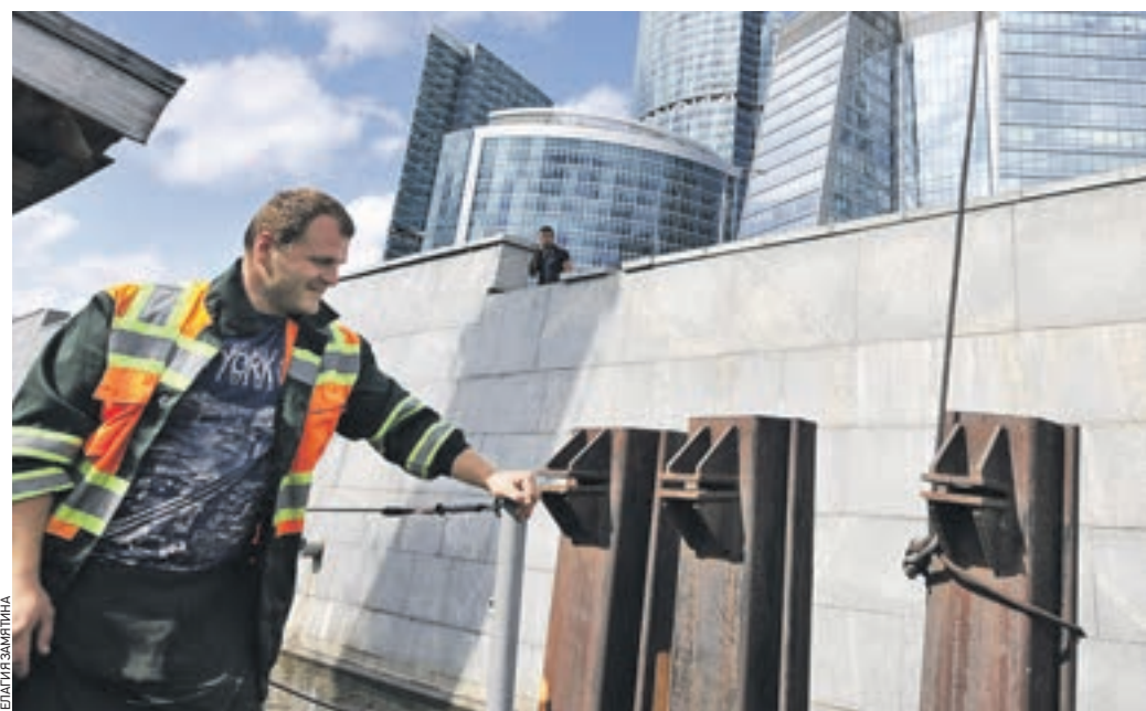
Вчера 11:47 Сотрудник ГУП «Мосводосток» Владимир Оборин контролирует демонтаж свай на Пресненской набережной
