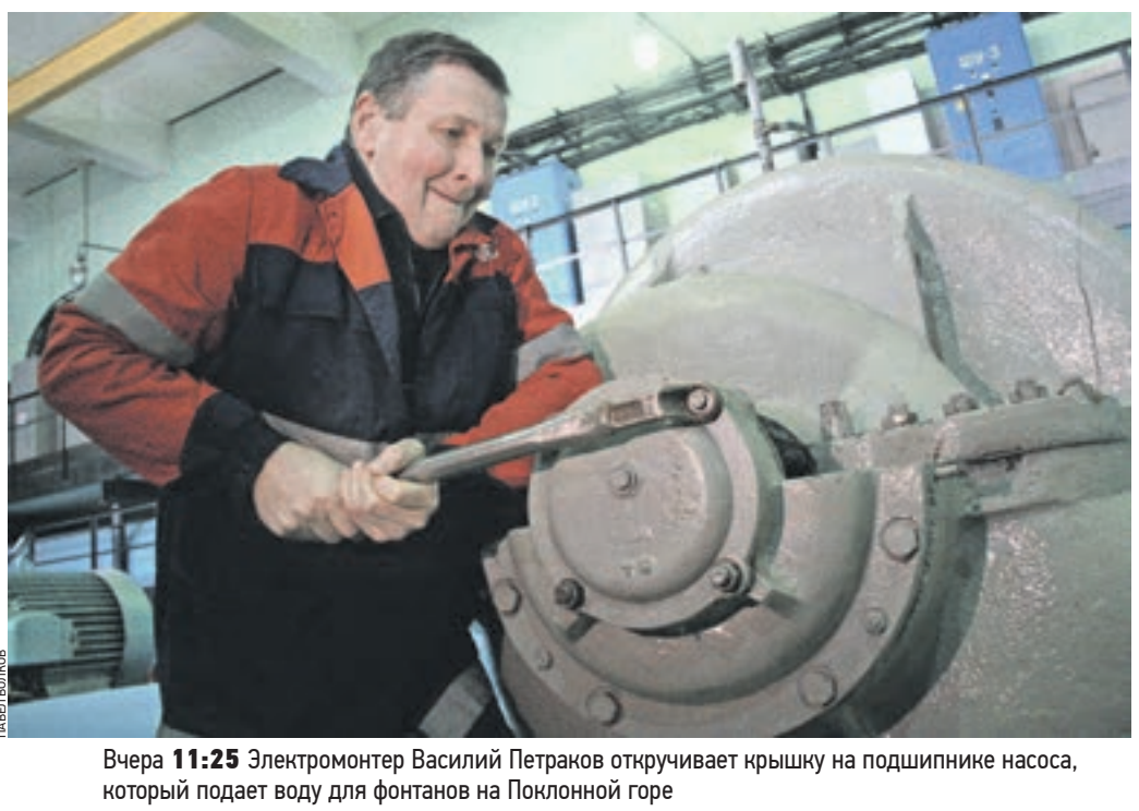
Вчера 11:25 Электромонтер Василий Петраков откручивает крышку на подшипнике насоса, который подает воду для фонтанов на Поклонной горе
