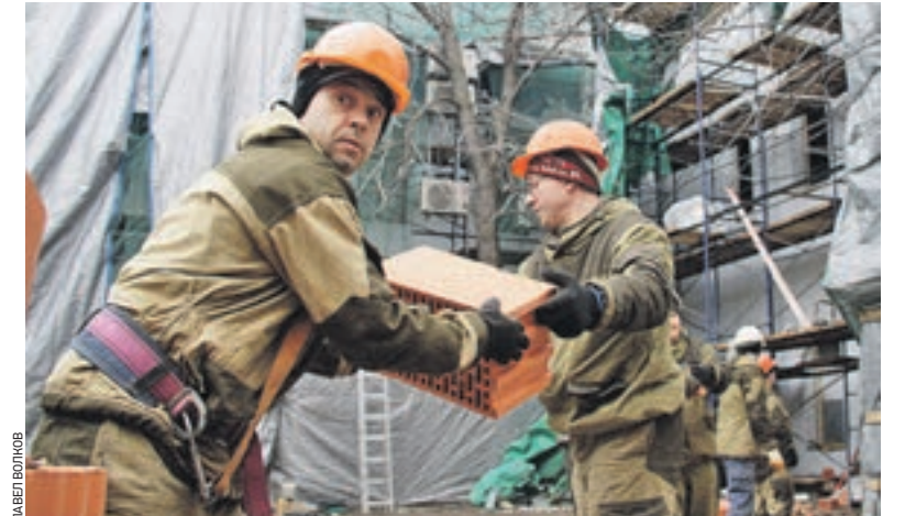
22 марта 08:00 Рабочие начинают демонтаж самостроя, возникшего во дворе памятника архитектуры
