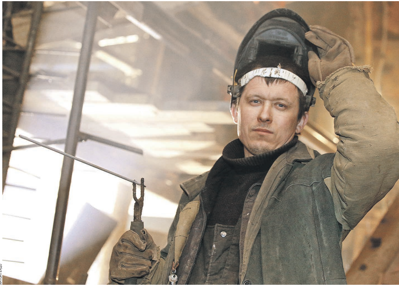
Вчера 11:00 Сварщик Иван Бобров на строительстве станции метро «Нижняя Масловка» Большой кольцевой линии Московского метрополитена
