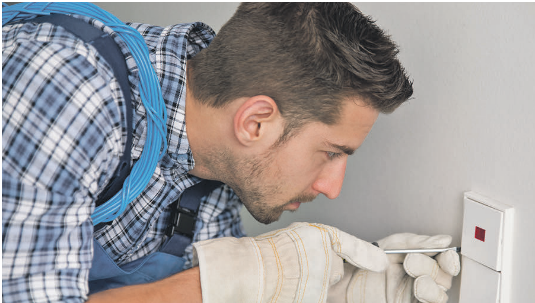
18 июля 2019 года. Частный электрик ремонтирует розетку. Как поясняют эксперты, главная проблема «мужей на час» в том, что они, как правило, работают нелегально и не дают никаких гарантий качества выполненных работ
