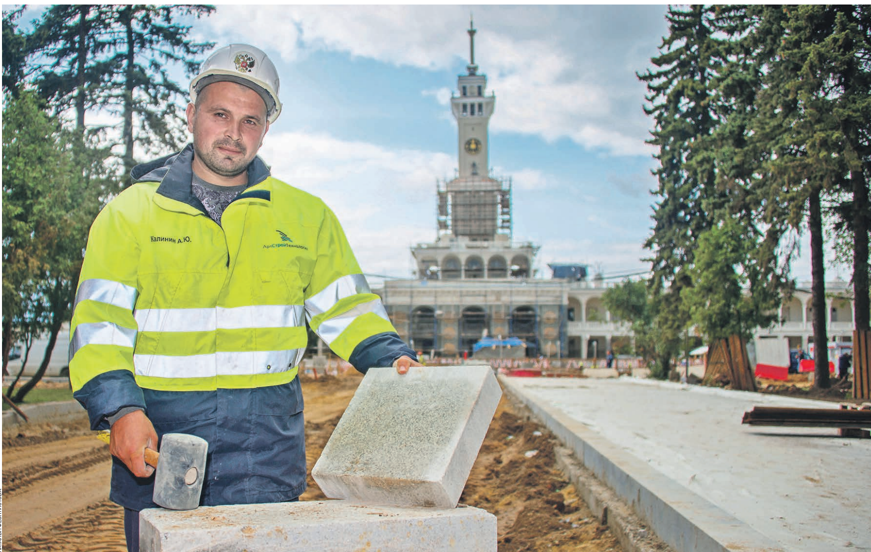
14 августа 13:20 Представитель компании-подрядчика Андрей Калинин проверяет качество привезенных стройматериалов. Сегодня работы по благоустройству парка Северного речного вокзала вышли на финишную прямую, в сентябре основную их часть завершат
