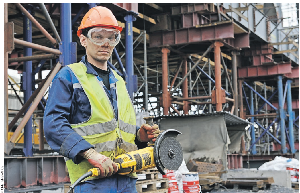
14 августа 13:39 Рабочий Сергей Ерунцов проводит резку элементов железных конструкций на реконструируемом участке между станциями Каланчевская и Курская
