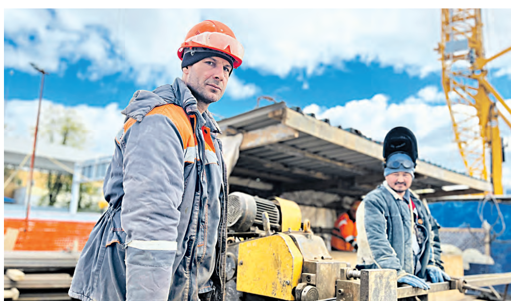
6 мая 11:32 Арматурщик Федор Муравьев (слева) и сварщик Султан Байбусинов в составе бригады возводят станцию «Аэропорт Внуково» Солнцевской линии метро
