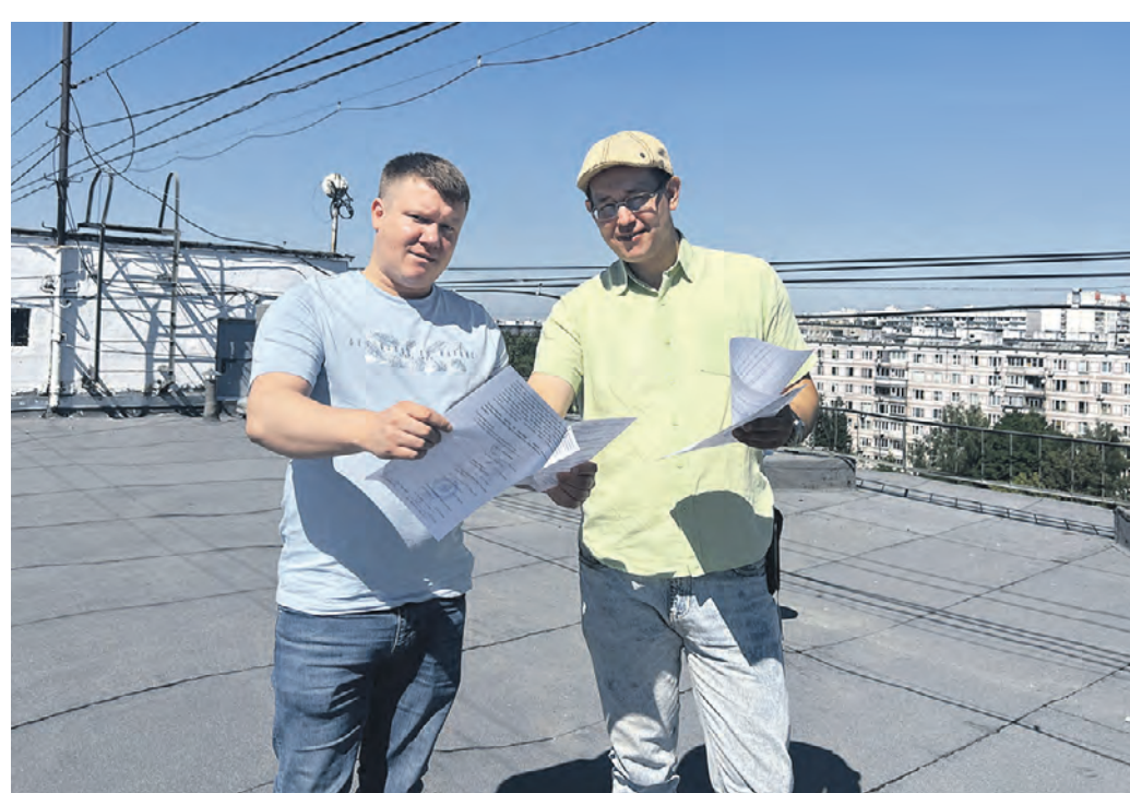
8 июля. Начальник отдела ГБУ «Жилищник района Орехово-Борисово Южное» Артем Алаев (слева) и муниципальный депутат Максим Демченков на кровле крыши дома № 8, корпус 1, на Ясеневоулице. Фото: Рената Лебедева
