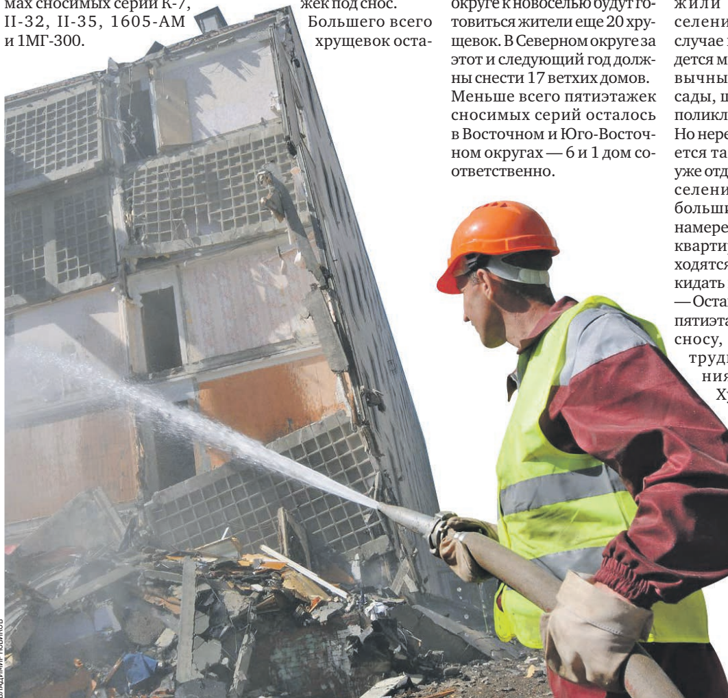
21 июля 2014 года. Пятиэтажный дом сносят в Свиблове. Поднявшуюся пыль сбивают водой
