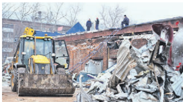
31 октября 2016 года. Демонтаж самостроя у станции метро «Петровско-Разумовская»
