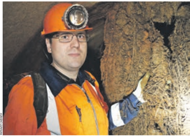
Вчера 00:22 Максим Сметанин показывает корни деревьев, которые с поверхности пробивались сквозь бетон к чистой воде
