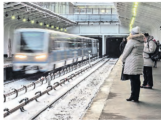
▶ 15 декабря 2016 года. Поезд проходит без остановки ремонтируемую северную платформу станции «Фили»
