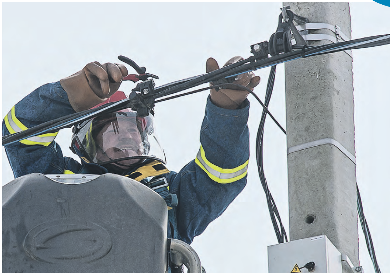
► 14 марта 2017 года 12:40 Электромонтер Сергиево-Посадского района электрических сетей Александр Прозоров участвует в рейде «Честный киловатт»
