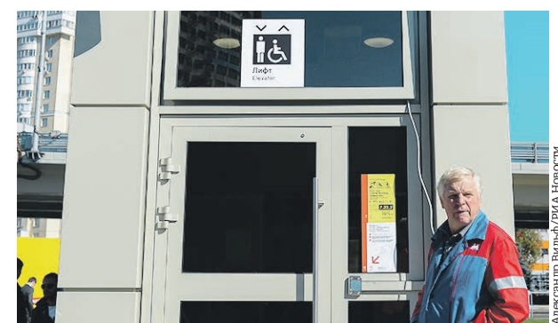
21 октября 2017 года. Лифт на станции «Котельники»
