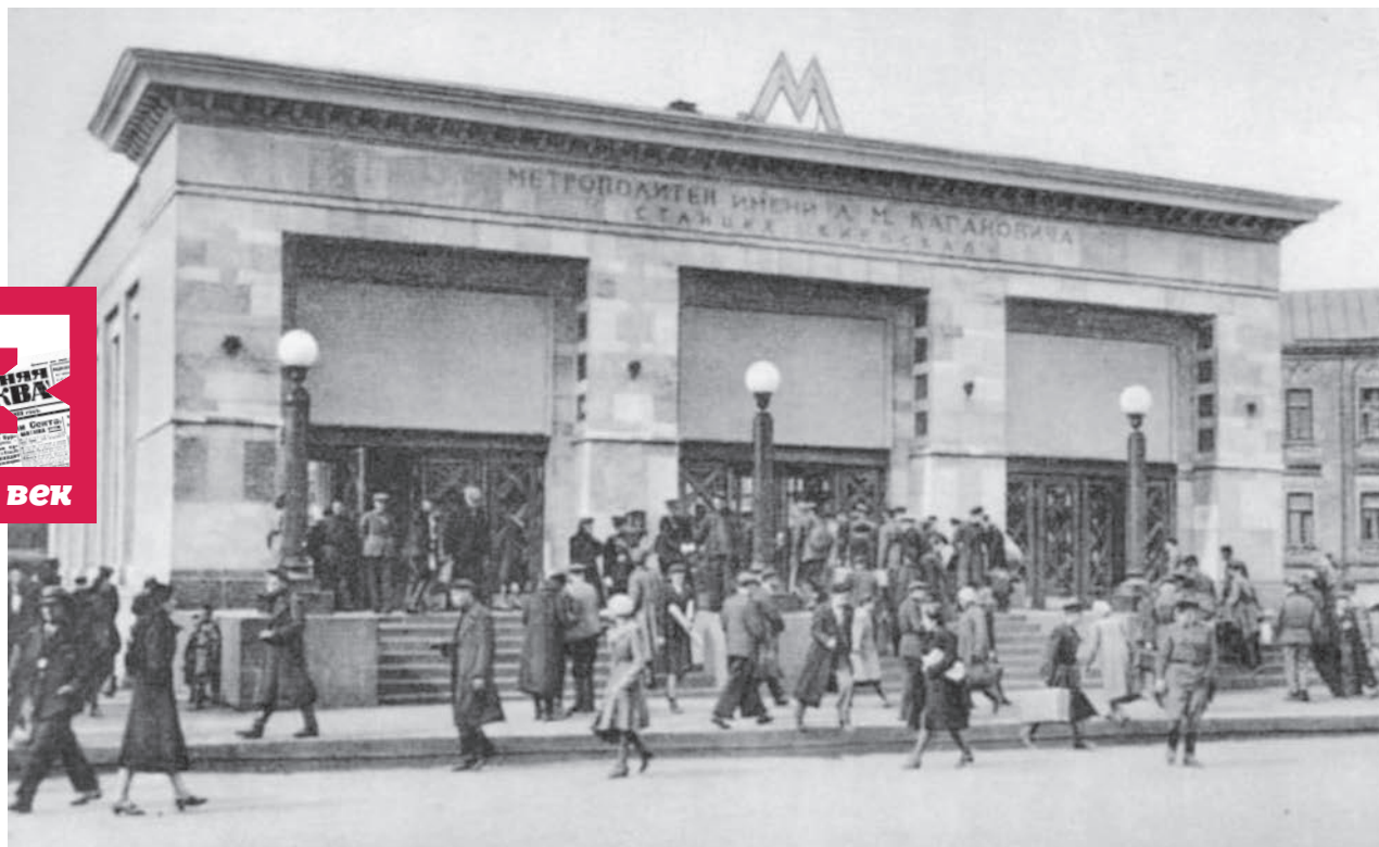
1935 год. Советские труженики на входе в наземный павильон станции Московского метрополитена «Киевская»
