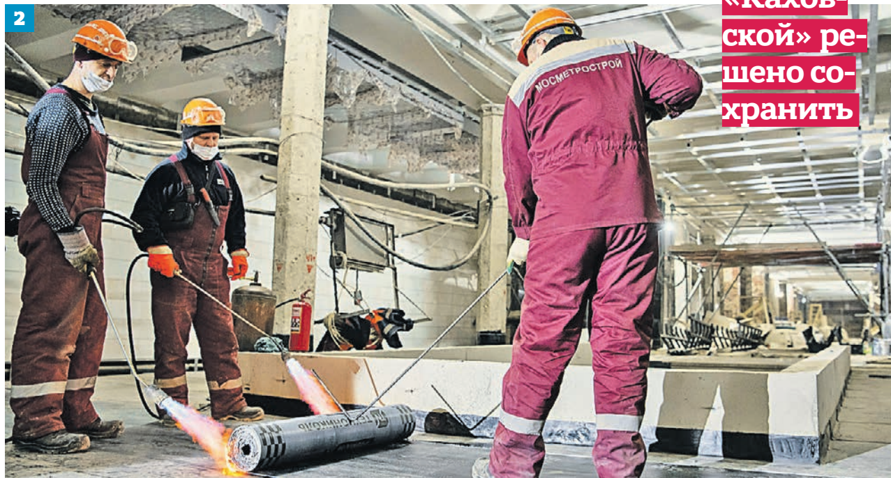
Визуализация будущей станции «Новаторская» Большой кольцевой линии столичного метрополитена (1). Рабочие ведут укладку гидроизоляции на платформе станции «Каховская» (2)
