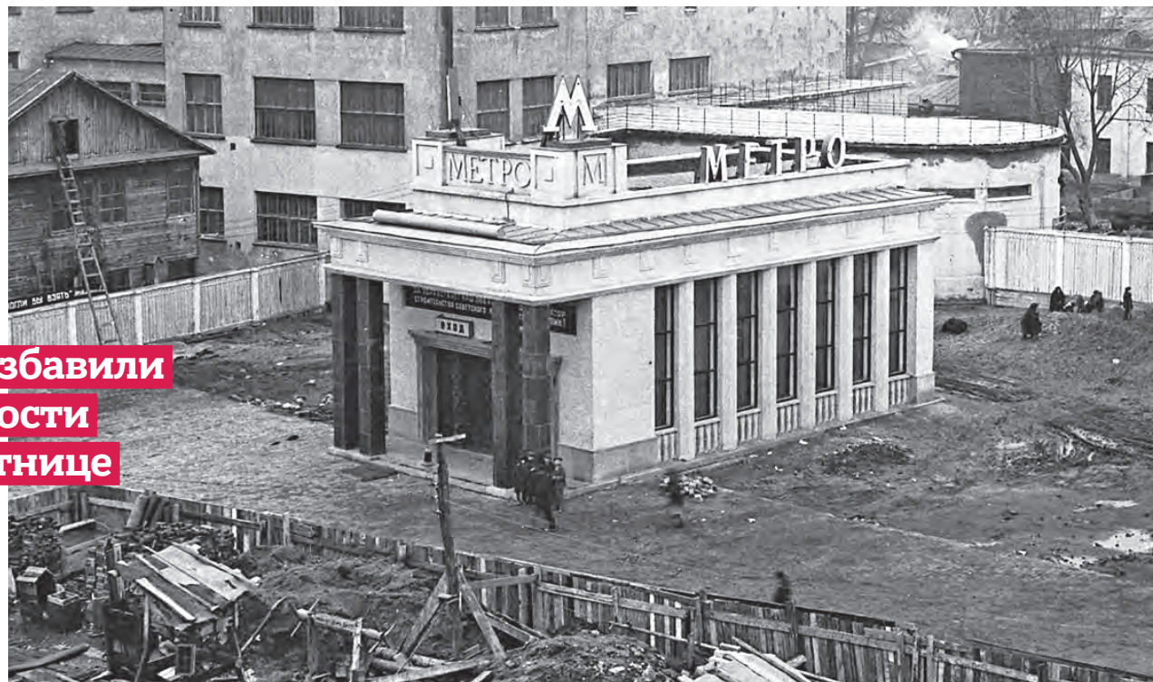
Начало 1930-х годов. Строительство южного наземного вестибюля станции метро «Крымская площадь» (сейчас — «Парк культуры»)
